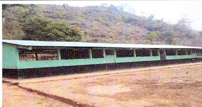
Estructura de entechado de la escuela
