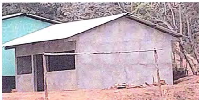
Rehabilitación de cocina culminada
