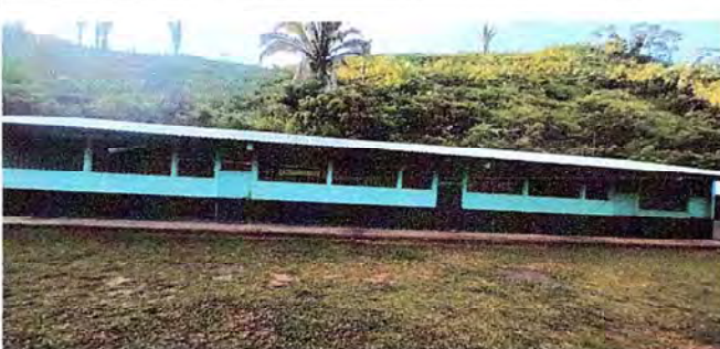
Vista frontal del entechado de la escuela.
