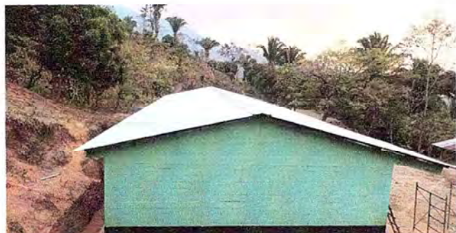
Foto 1: Sustrución de soporte de madera por metal, así como el cambio de lamina.
