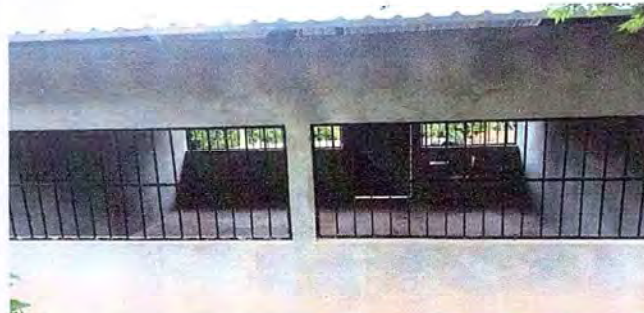
Foto 2: rehabilitacion de cocina concluida
